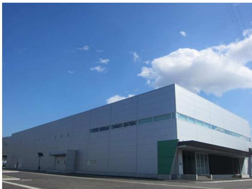
生産技術研究棟
